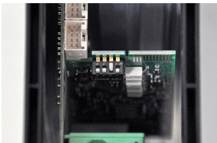
Voor generator C: 2 omhoog
